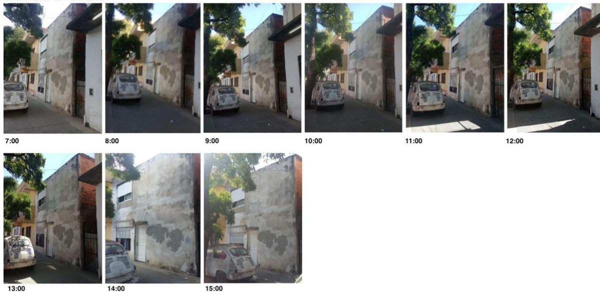
Figura 15. Asoleamiento de la fachada de Pola 3966, 22/03/24. Fuente: elaboración propia
