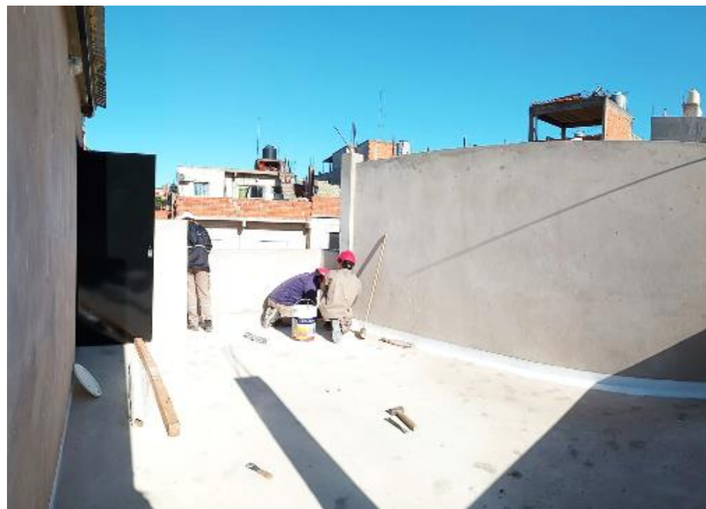
Fotografías de ejecución de obra en vivienda de manzana 15 orden 38. En las primeras dos fotografías se puede observar la construcción del doble muro con cámara de aire y en la tercera fotografía la colocación de pintura blanca sobre la terraza Diseño realizado por el equipo territorial del IVC y vecinos del Barrio 20.
