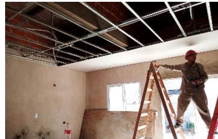
Fotografías tomadas en distintas obras de mejoramiento. Imagen 1: Colocación de pintura clara en vivienda con orientación norte. Imagen 2: Colocación de cielorraso y aislante térmico aluminizado con cámara de aire de 1 metro. Imagen 3: Pintura blanca en el solado de la terraza.
