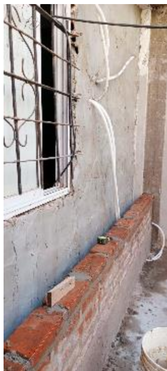
Fotografías de ejecución de obra en vivienda de manzana 15 orden 38. En las primeras dos fotografías se puede observar la construcción del doble muro con cámara de aire y en la tercera fotografía la colocación de pintura blanca sobre la terraza Diseño realizado por el equipo territorial del IVC y vecinos del Barrio 20.
