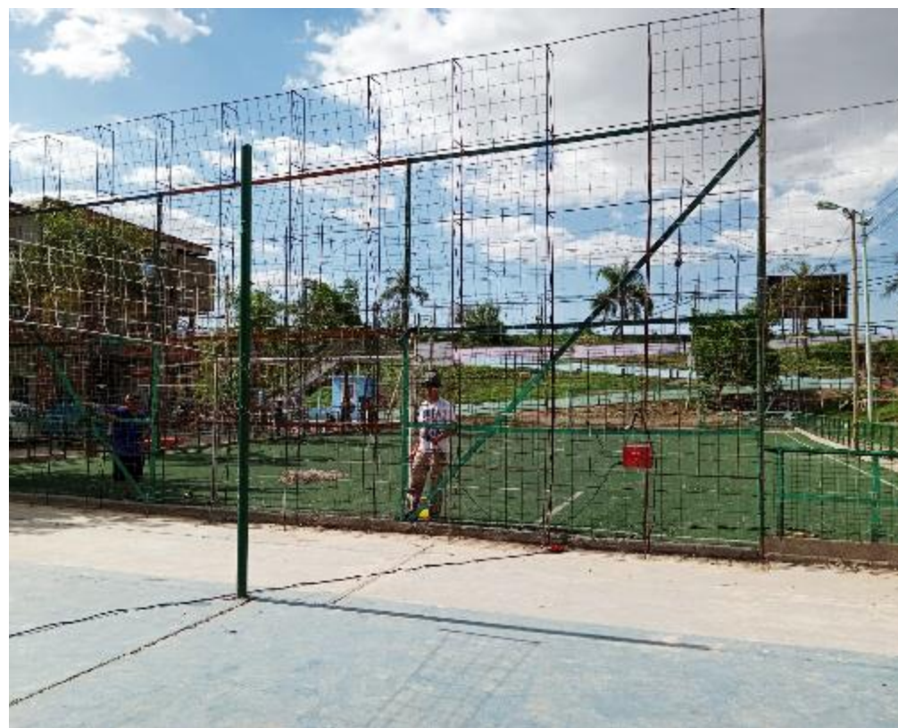
Fotografías de ejecución de obra en la Plaza de las Risas. Diseño para TUC realizado en colaboración por el paisajista Gabriel Burgueño, Arq. Mariana Giusti, Arq. Gabriel La Valle, IVC y vecinos del Barrio 20.
